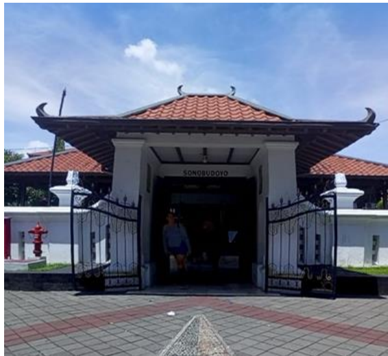
Gambar 5. Tampak Pintu Masuk Museum Sonobudoyo Sumber : Dokumentasi Penulis
